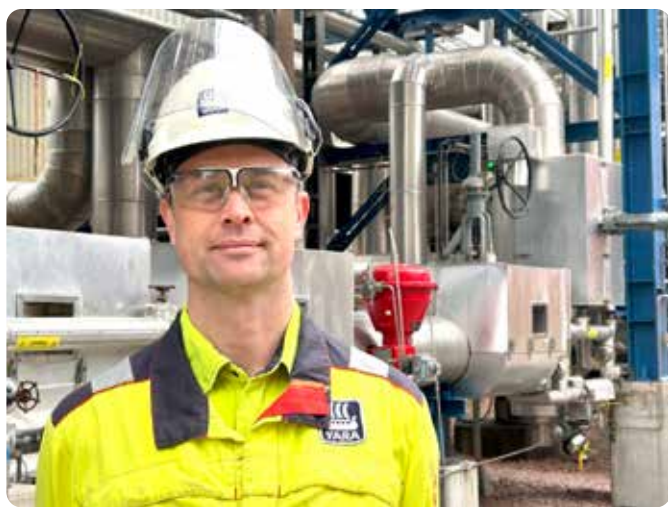
Axel Sylvén är platschef vid Yara. Det omfattande rörnätet i anläggningen är en del av megainvesteringen i processindustrin vid Nya Hamnvägen i Köping. (Foto: Ulf Eneroth)
